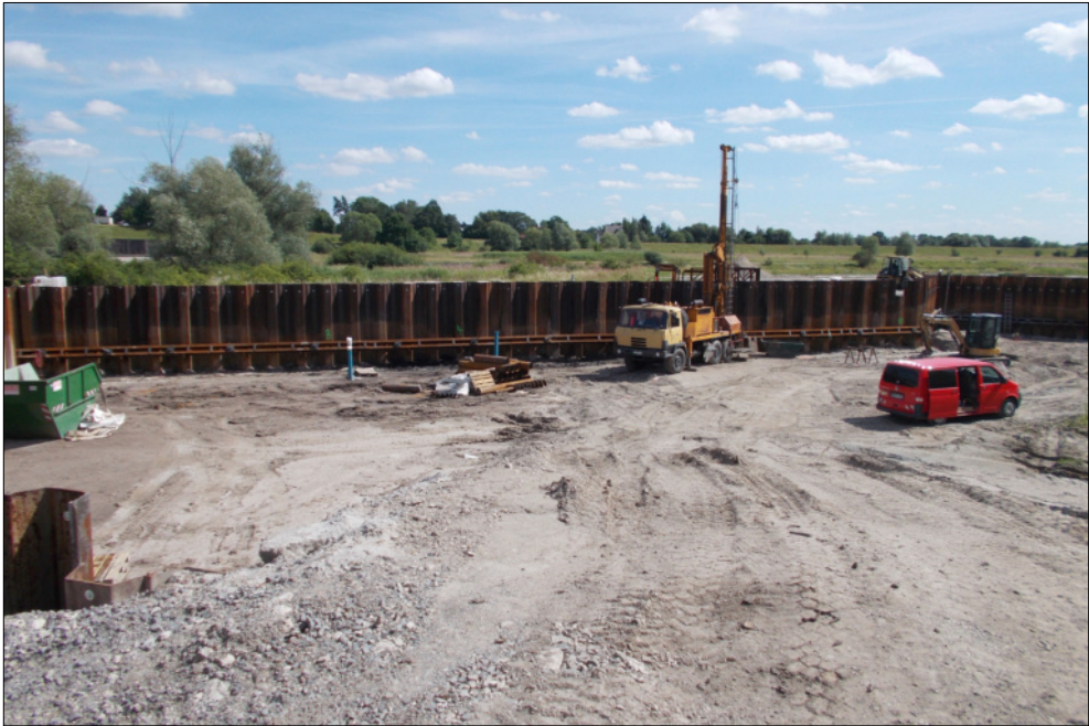
Abb. 3: Standort der Brunnenbohrung 5/2017 auf der Baustelle. (Foto: H. Gutjahr)
