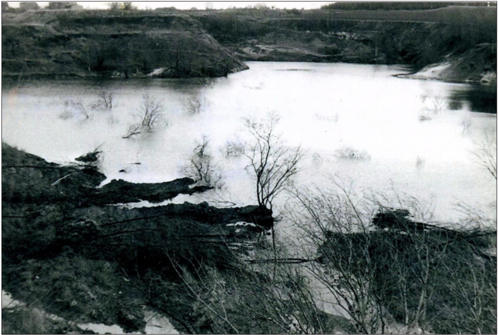
Abb. 4: Das Tagebaurestloch der Grube Nr. 397 Reußen kurz nach der Rutschung im Jahre 1965. (Foto: H.-J. Bellmann)
