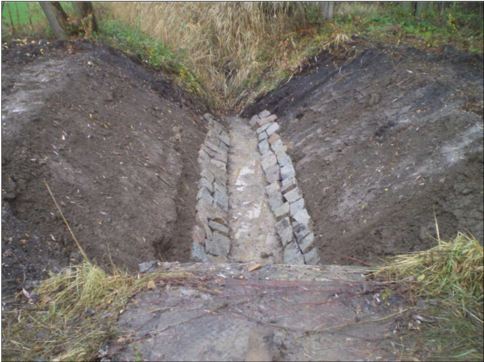
Abb. 22: Ableiter im Bereich des rückgebauten Messwehres an der Kleingartenanlage Falkenhain (Blick nach Südwesten mit Böschungsfußsicherung).
