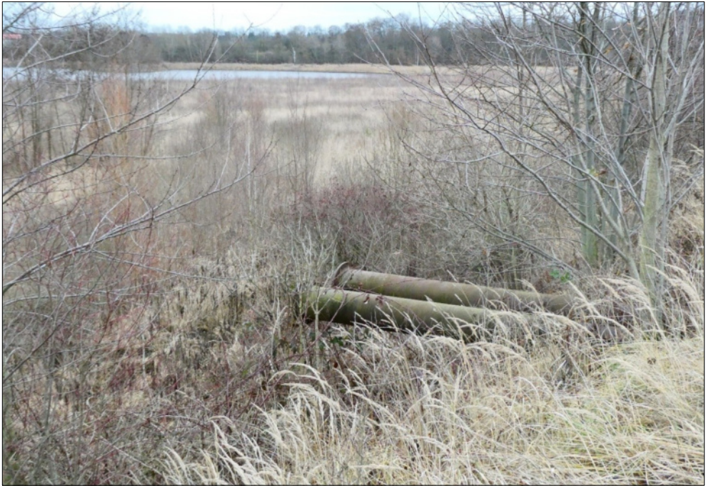
Abb. 13: Ehemaliger Ablauf für Überschusswasser (Aschebecken 1.2 am Damm 4), Dezember 2022.
