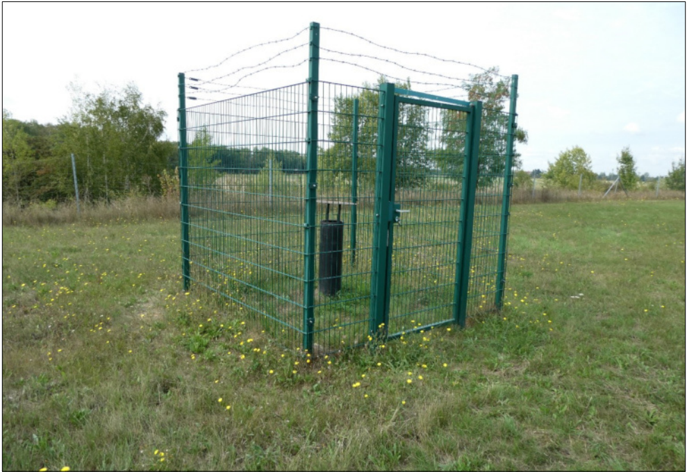
Abb. 9: Passiver Entgasungsschacht pES 3 auf der Hyzet-Kippe, 2022.
