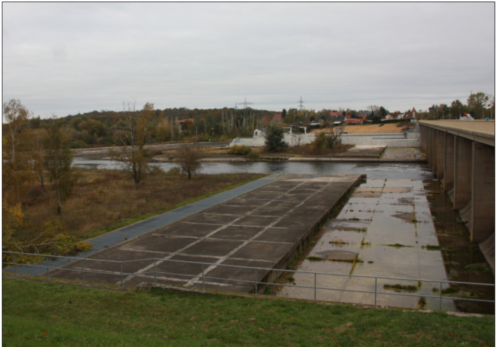
Abb. 2: Blick von Friedersdorf in Richtung Auslaufwehr Muldestausee mit dem neuen Wasserkraftwerk unterhalb vom Steinberg bei Muldenstein.
