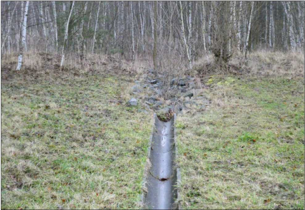
Abb. 7: Ableitung von Oberflächenwasser am Böschungsfuß der Hyzet-Kippe, 2022.
